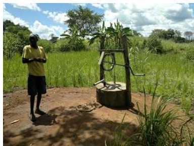
Poço com bomba de corda Clube 1º de Maio
